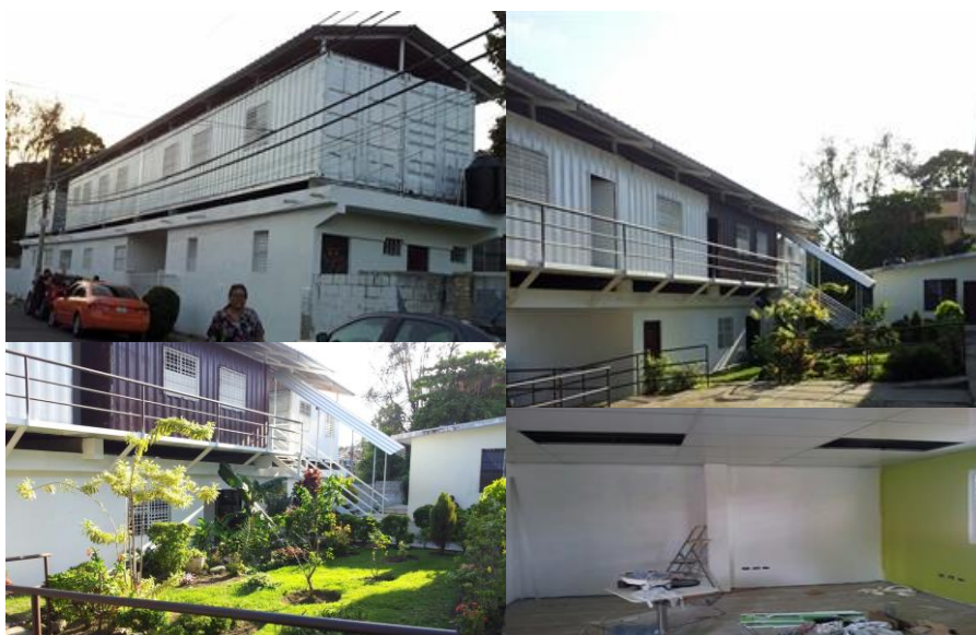
Los contenedores en diciembre de 2015 ya convertidos en aulas. Fueron techados, aislados contra el calor y provistos de instalaciones eléctricas. Ya están prácticamente terminados y aptos para recibir el mobiliario.
