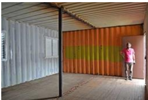
Estado de los contenedores en abril de 2015 antes de la habilitación.
